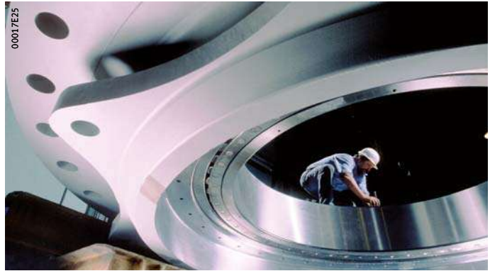
Ilustr. 5 Montaż dużego łożyska tocznego
